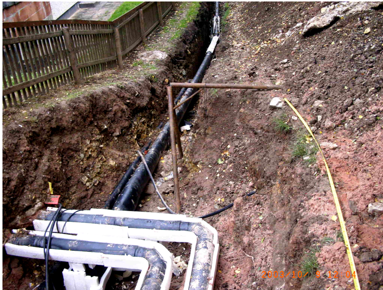
Rohrverlegung im Graben
