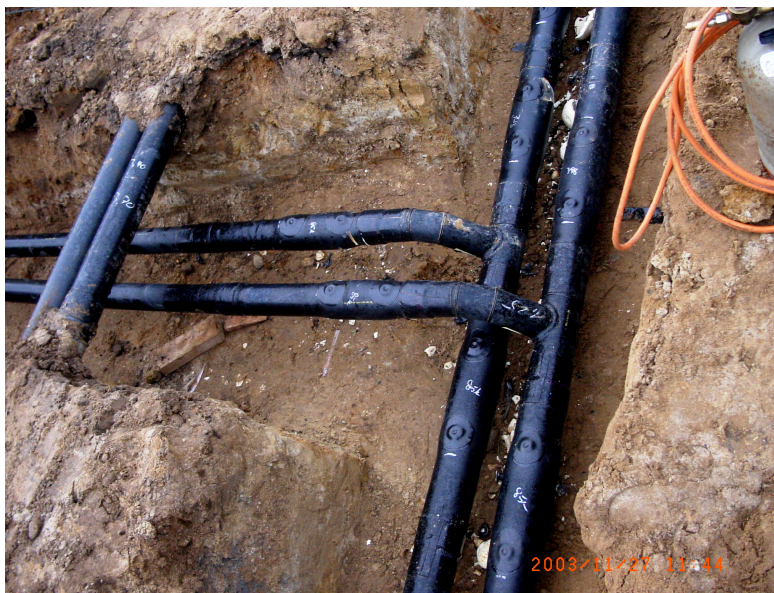
Rohrverlegung zum Hausanschluss mit KMR
